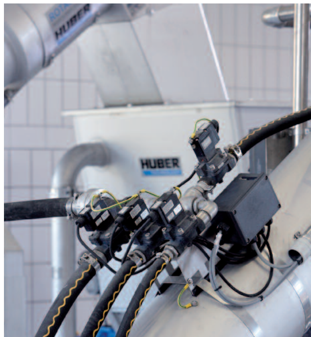
ROTAMAT® pöörlev trummelpuensõel sisseehitatud sõelmete pesemissüsteemiga IRGA
