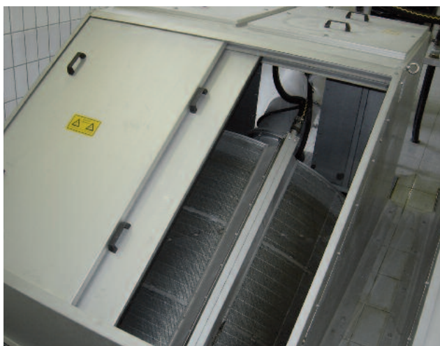
ROTAMAT® pöörlev trummelpesõel Ro 2 on paigaldatud kanalisse, millel on liigutatav roostevabast terasest kate, suurus 600 kuni 3000.
